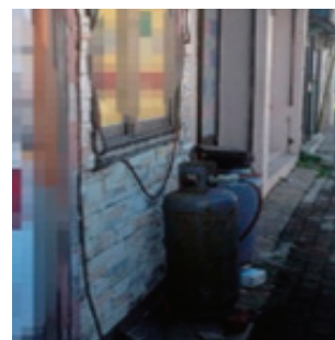
가스 연결호스가 과도하게 길게 설치된 경우
