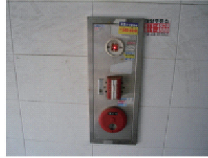
▲ 위치표시등의 파손을 방지한 경우
