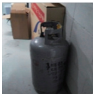
가스 저장용기 설치장소에 아무렇게나 방치
